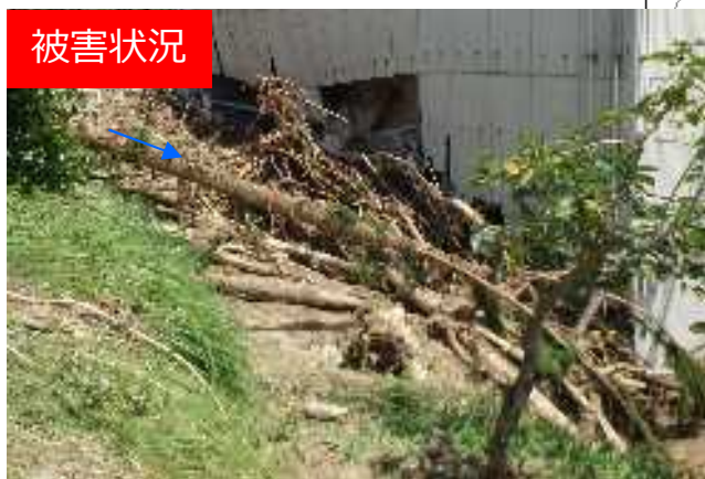
土砂流出状況
