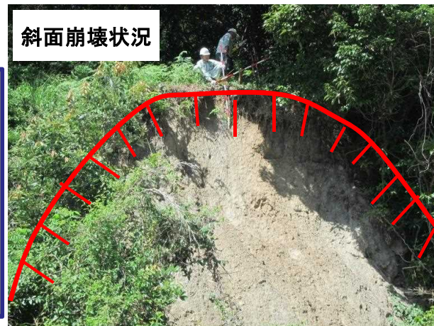
斜面崩壊状況
