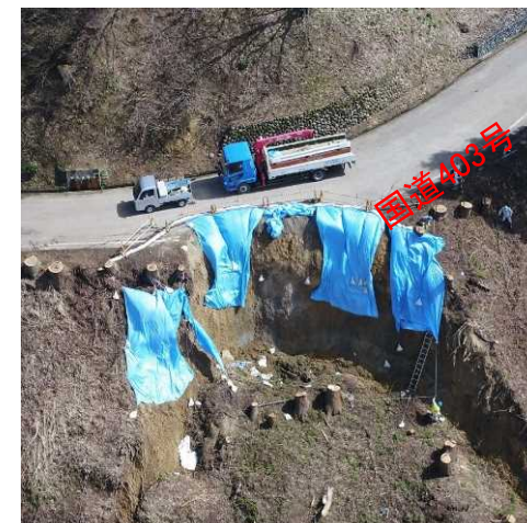
①国道被害状況
