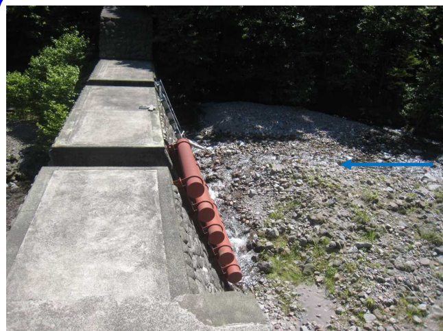
左岸より上流側を望む
