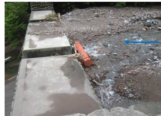
左岸側より上流側を望む
