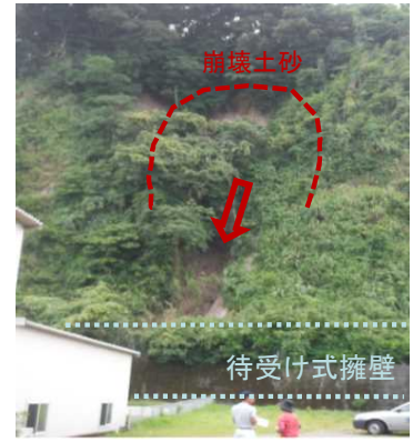
砂防関係施設が崩壊土砂を捕捉 (鹿児島市坂之上地区)
