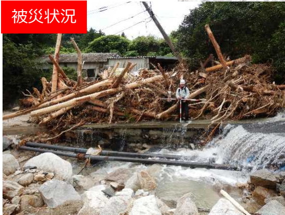
土砂堆積状況
