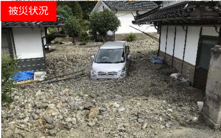
土砂堆積状況
