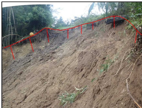
被害状況①(滑落崖の状況)
