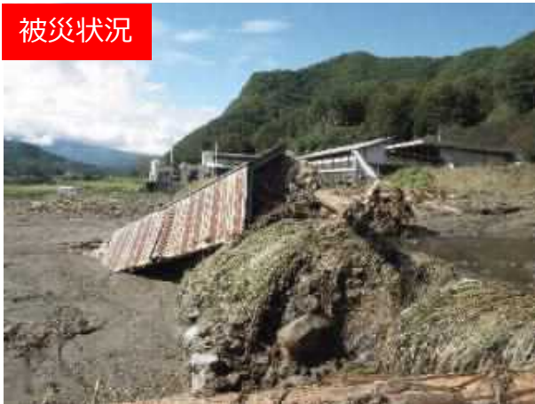
不安定土砂堆積状況
