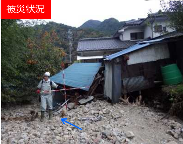
不安定土砂堆積状況
