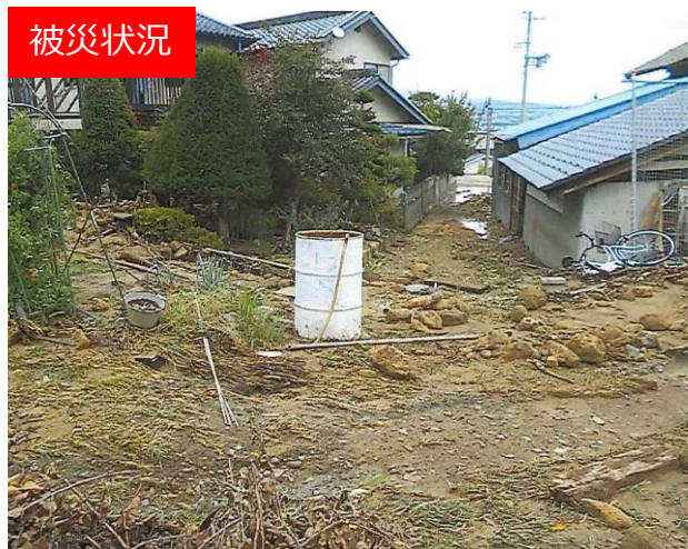
不安定土砂堆積状況
