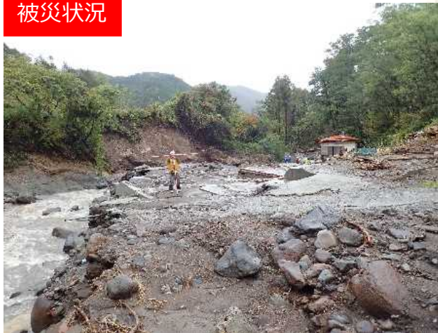
不安定土砂堆積状況
