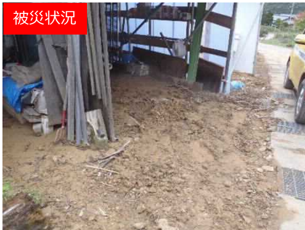
不安定土砂堆積状況
