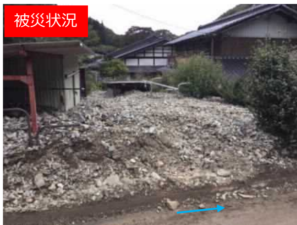
不安定土砂堆積状況
