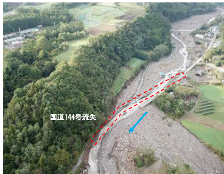
嬭恋村大笹地区の被災状況(吾妻川)
