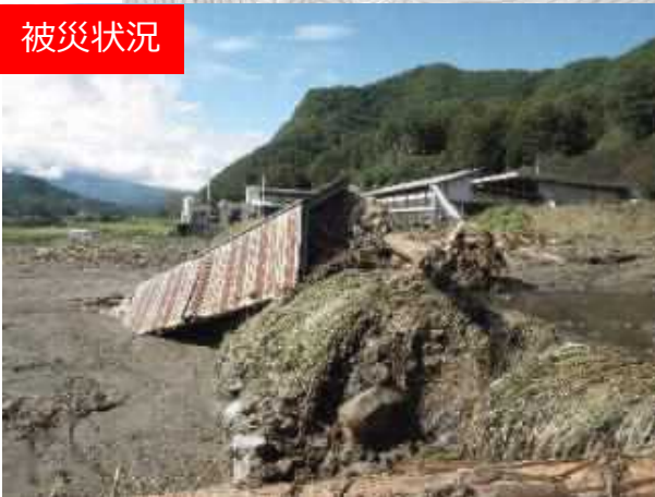
不安定土砂堆積状況
