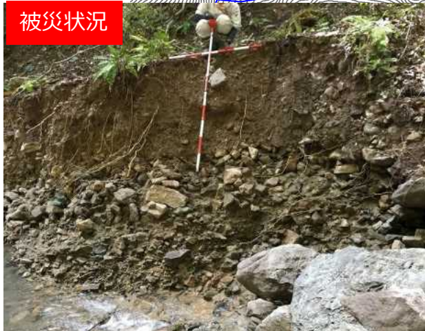
不安定土砂堆積状況
