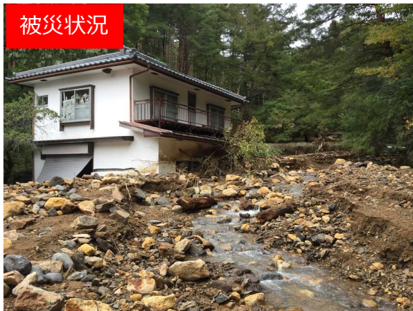
不安定土砂堆積状況
