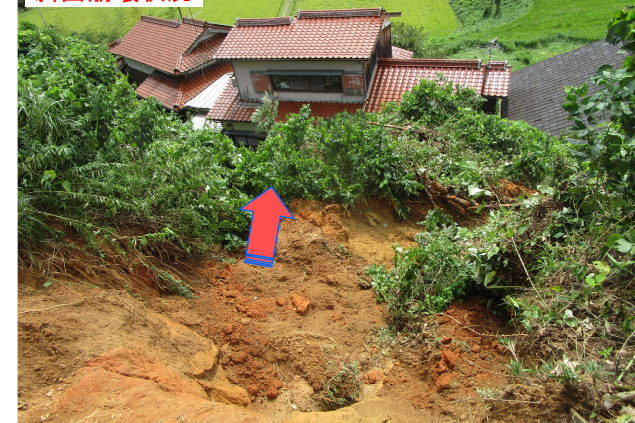
斜面崩壊状況
