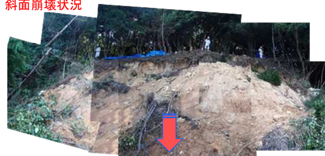
斜面崩壊状況
