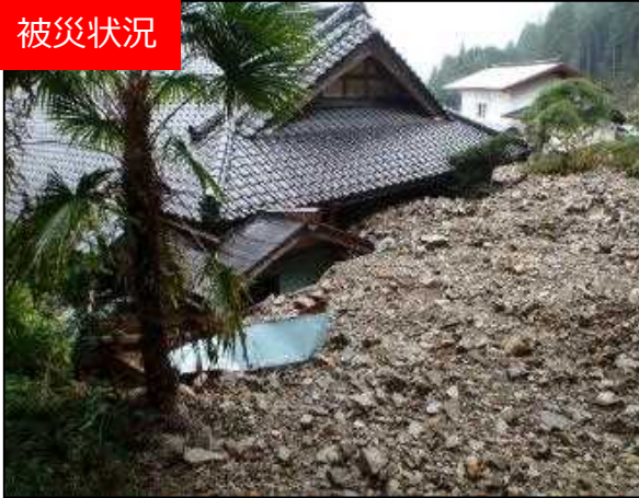
不安定土砂堆積状況
