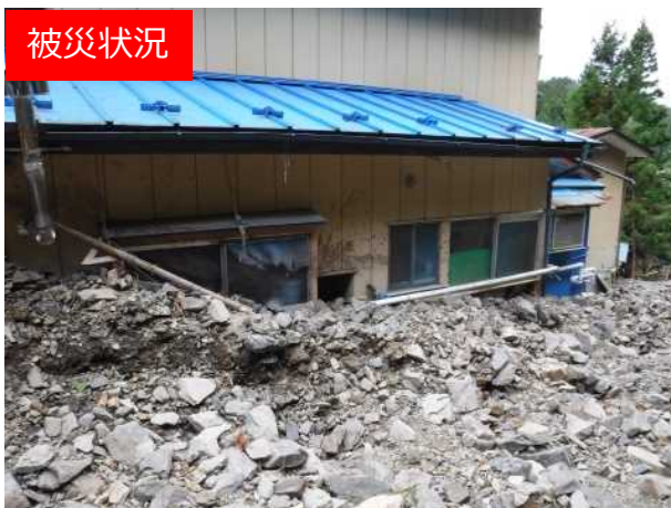
不安定土砂堆積状況
