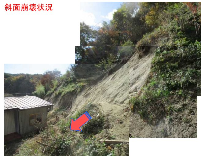
斜面崩壊状況
