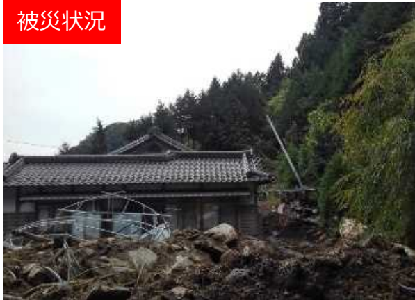
不安定土砂堆積状況
