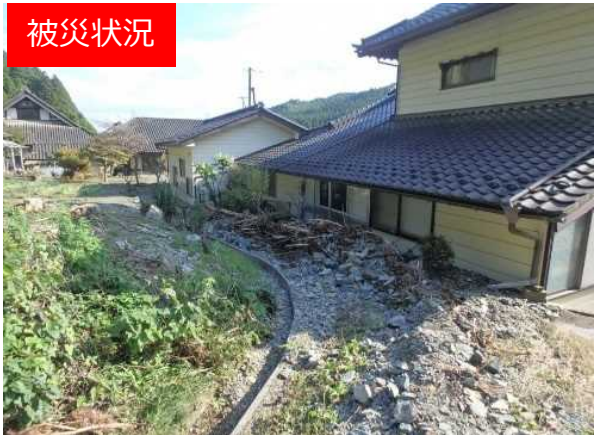
不安定土砂堆積状況
