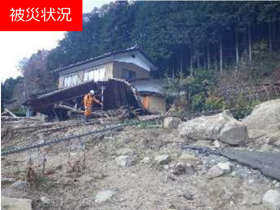
不安定土砂堆積状況
