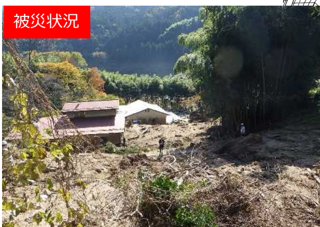
不安定土砂堆積状況
