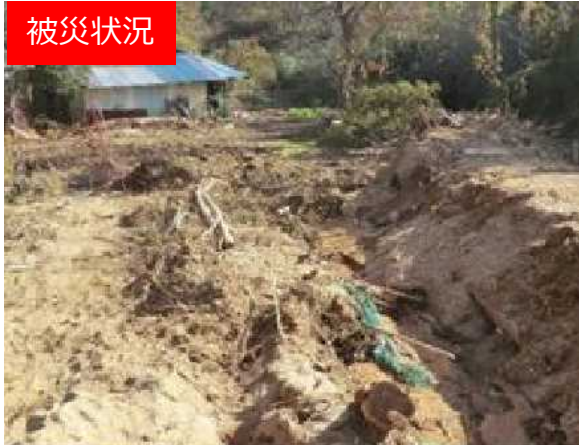
不安定土砂堆積状況
