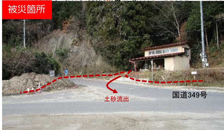
不安定土砂堆積状況
