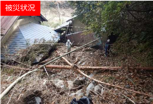
不安定土砂堆積状況
