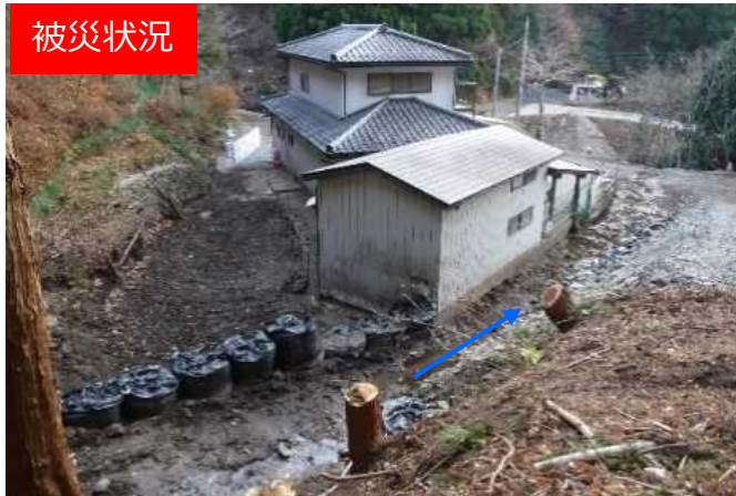
不安定土砂堆積状況
