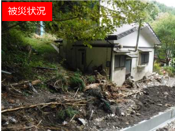
不安定土砂堆積状況
