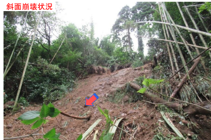
斜面崩壊状況
