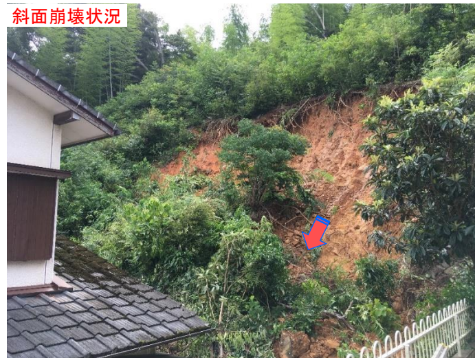
斜面崩壊状況
