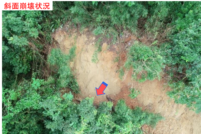
斜面崩壊状況
