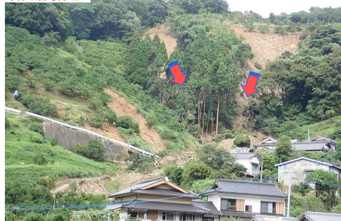
斜面崩壊状況
