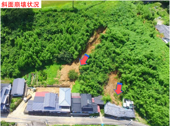
斜面崩壊状況
