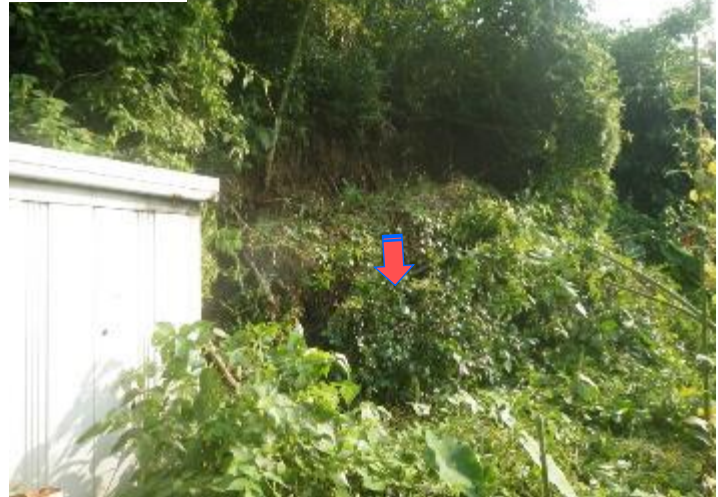
斜面崩壊状況
