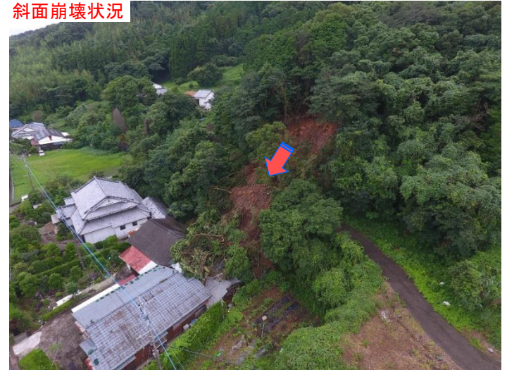
斜面崩壊状況
