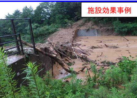
施設効果事例 砂防えん堤が土石流を捕捉
