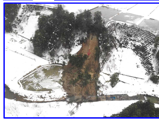
1/4発生 土石流等 なかにいかわ たてやままち あしみ 富山県中新川郡立山町芦見
