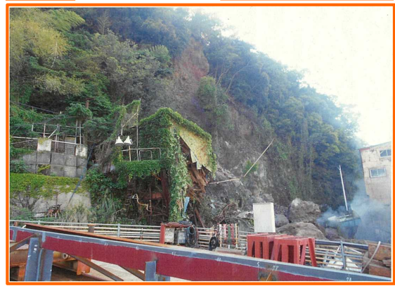
5/23発生 ながさき とまち がけ崩れ 長崎県長崎市戸町
