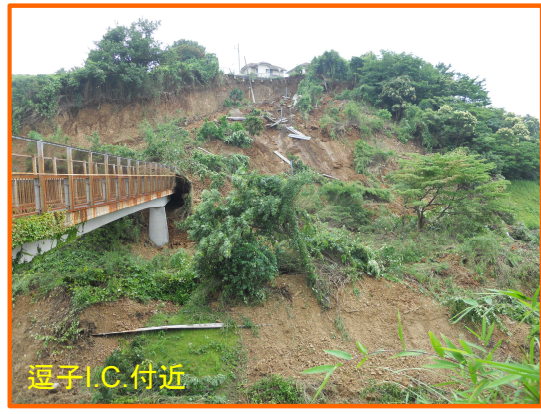
7/3 がけ崩れ ずし めまま 神奈川県逗子市沼間
