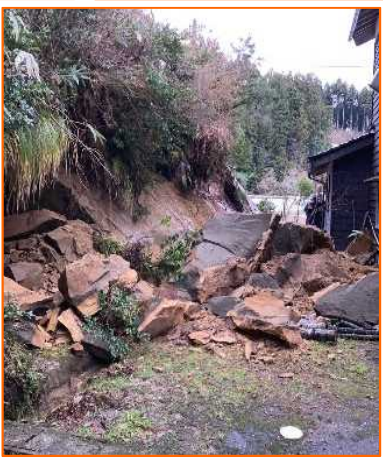
1/6 すずし しょういんまちいづか 石川県珠洲市正院町飯塚 がけ崩れ
