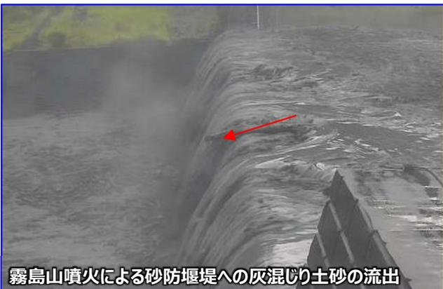
霧島山噴火による砂防堰堤への灰混じり土砂の流出
