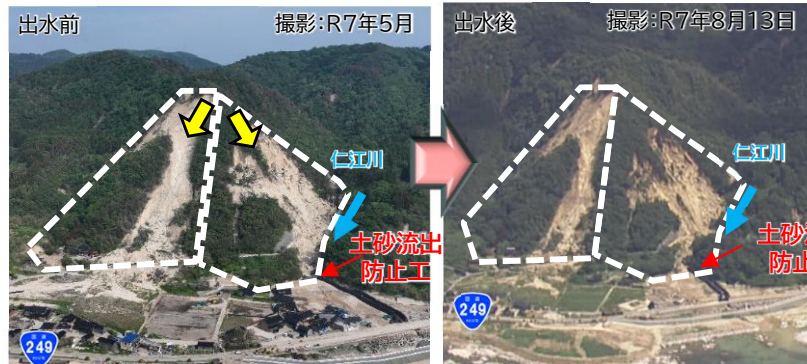
地すべりブロック全景: 変状無し
