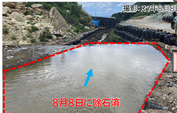
土砂流出防止工による土砂捕捉の状況
