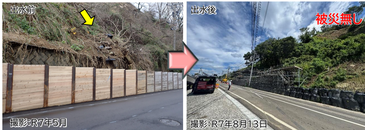
仮設防護柵工の整備状況
