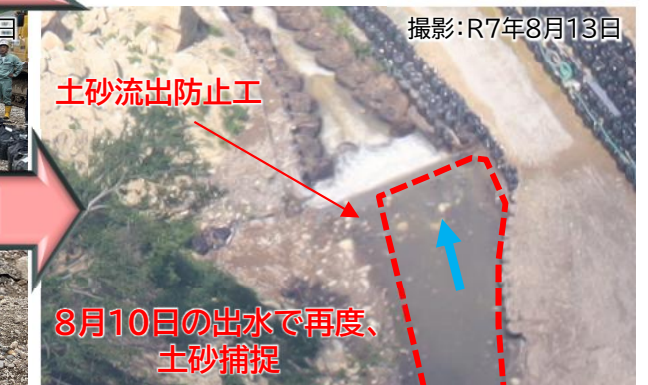
土砂流出防止工による土砂捕捉の状況
