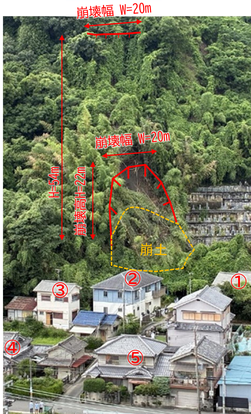
斜面の崩壊状況(斜面上部滑落崖)
