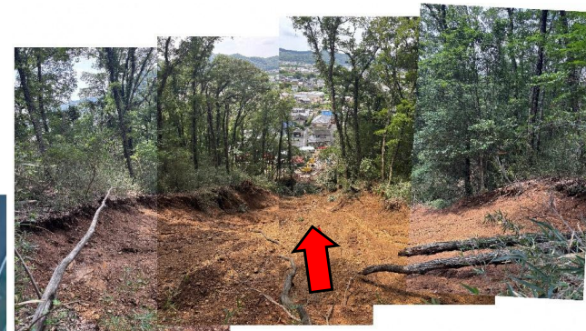
斜面南側の崩壊状況(頭部から崖下を望む)
