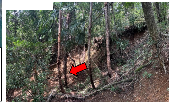
斜面北側の崩壊状況(斜面上部滑落崖)
