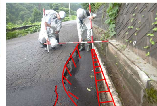
③既設側溝の状況
