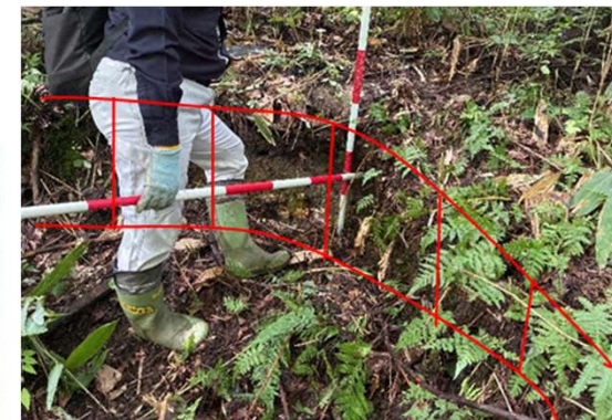
①段差状況
