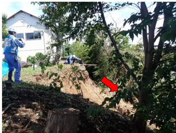
斜面の崩壊状況(滑落崖)
