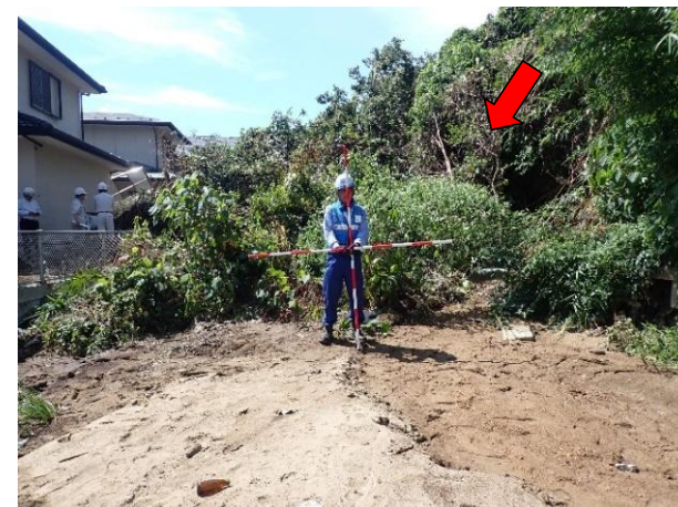
崩土等の堆積状況
