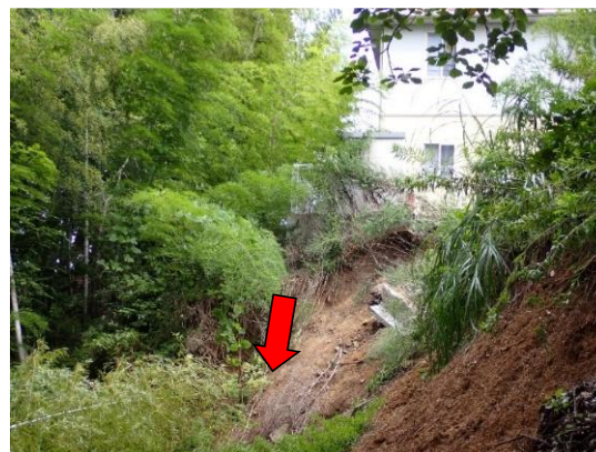
斜面の崩壊状況(斜面上部近景)
