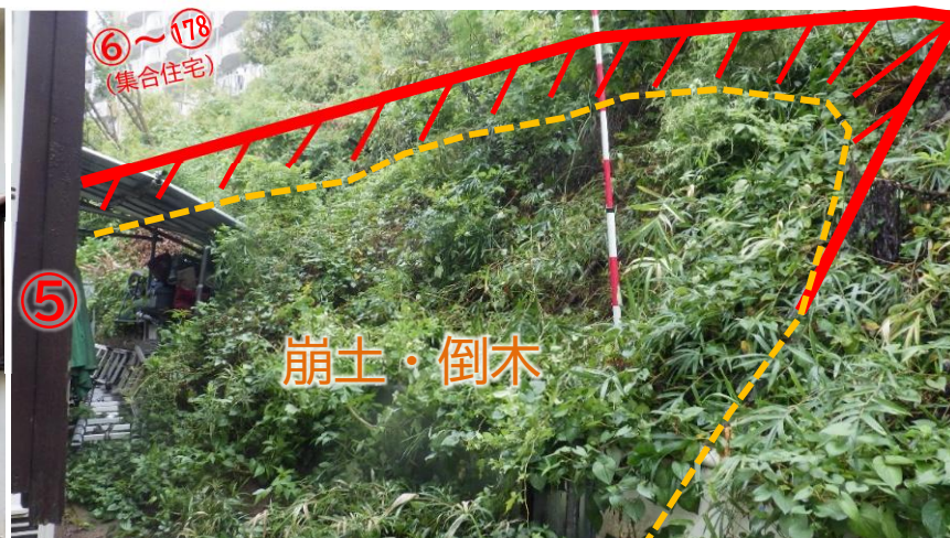
斜面崩壊の状況(近景)
